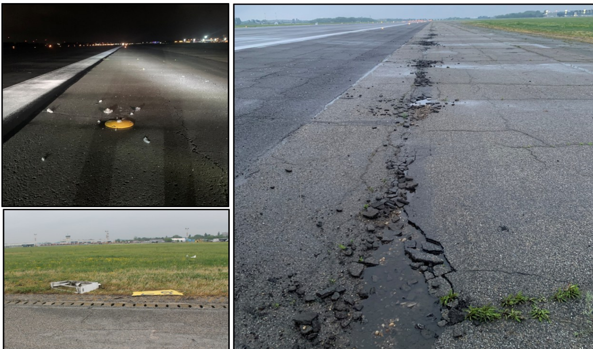
Figura 1 – Pagube produse suprafeței de mișcare (balize, banda de siguranță și panou de informare)
