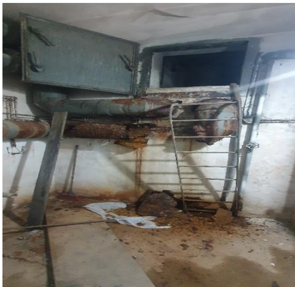
Fotografie nr 1: Ministerul Transporturilor-deficiențe la instalația de filtro-ventilație, ieșirea de urgență sursa: foto CCRO
