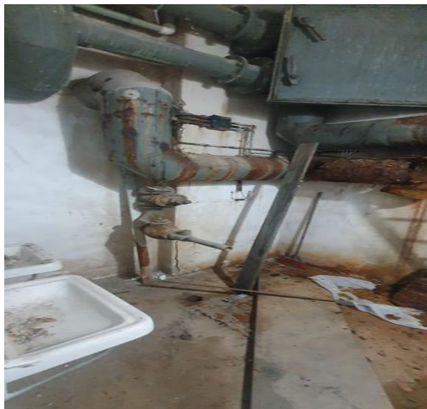
Fotografie nr 1: Ministerul Transporturilor-deficiențe la instalația de filtro-ventilație, ieșirea de urgență sursa: foto CCRO
